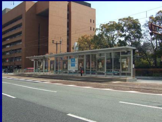
広告付き電停上屋(市役所前電停)
